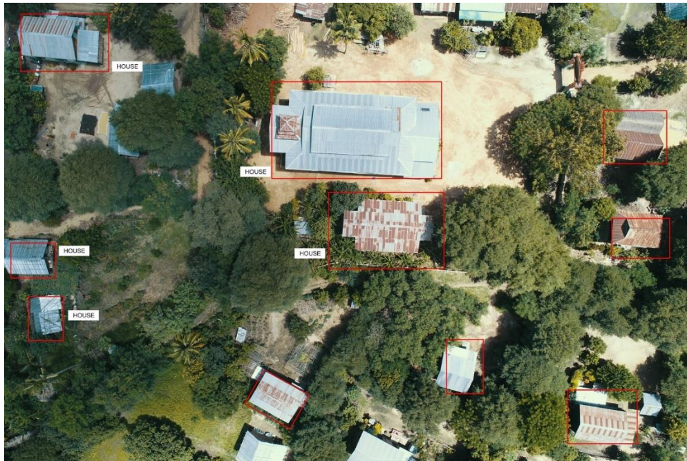
Annotierte Luftaufnahme aus einem Erdbebengebiet in Mozambique ©WFP und Fraunhofer ITWM
